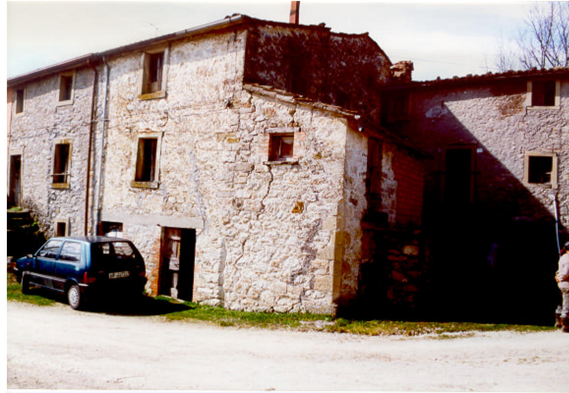
Foto 1: edifici lesionati presso l'abitato di Ca' Natello, nella zona sommitale della frana
